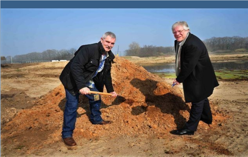
Hans van Montfoort (Netters Infra) zet de eerste schop in de grond voor de nieuwbouw van het pand van Netters Infra
